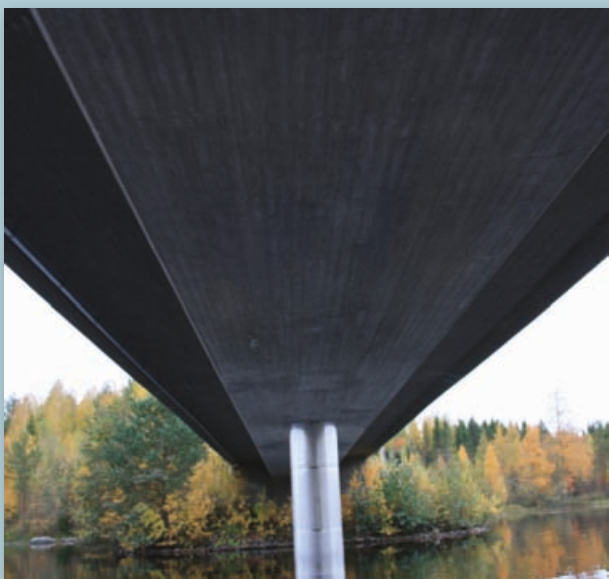
Kaasilansalmen sillan alta.
