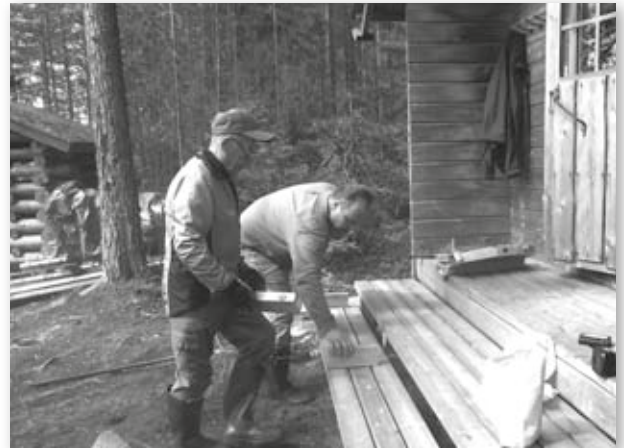
Kannaksen retkisatamassa laitettiin majaan uudet portaat. Kirvesmiehinä Seppo Heiskanen (vas.) ja Osmo Väisänen.
