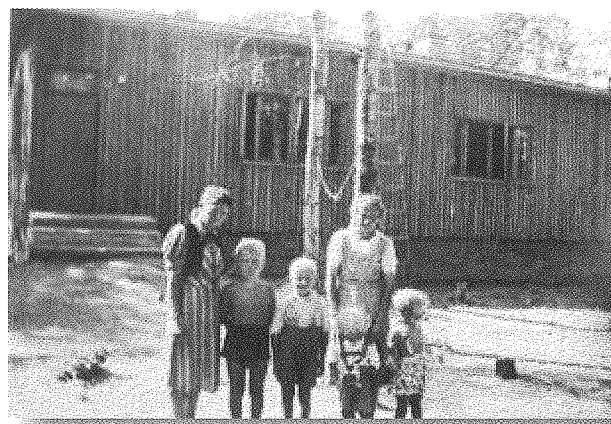
Ritoniemen ja Tuusniemen ns. aliupseeri- ja upseerikylän muodosti kymmenen loivakattoista parakkia. Ne rakennettiin pikavauhtia vuosien 1940 ja 1941 aikana. Ritoniemen upseerikylän talot käsittivät 3 h + keittiön ja palvelijan asunnon. Aliupseeritalot olivat 2 h ja keittiön kokoisia. Yksi rakennus varattiin kerhotilaksi. Rakennukset olivat kevytrakenteisia ja talvella kylmiä. Kuva: Rauno Ruohosen kokoelmista.
