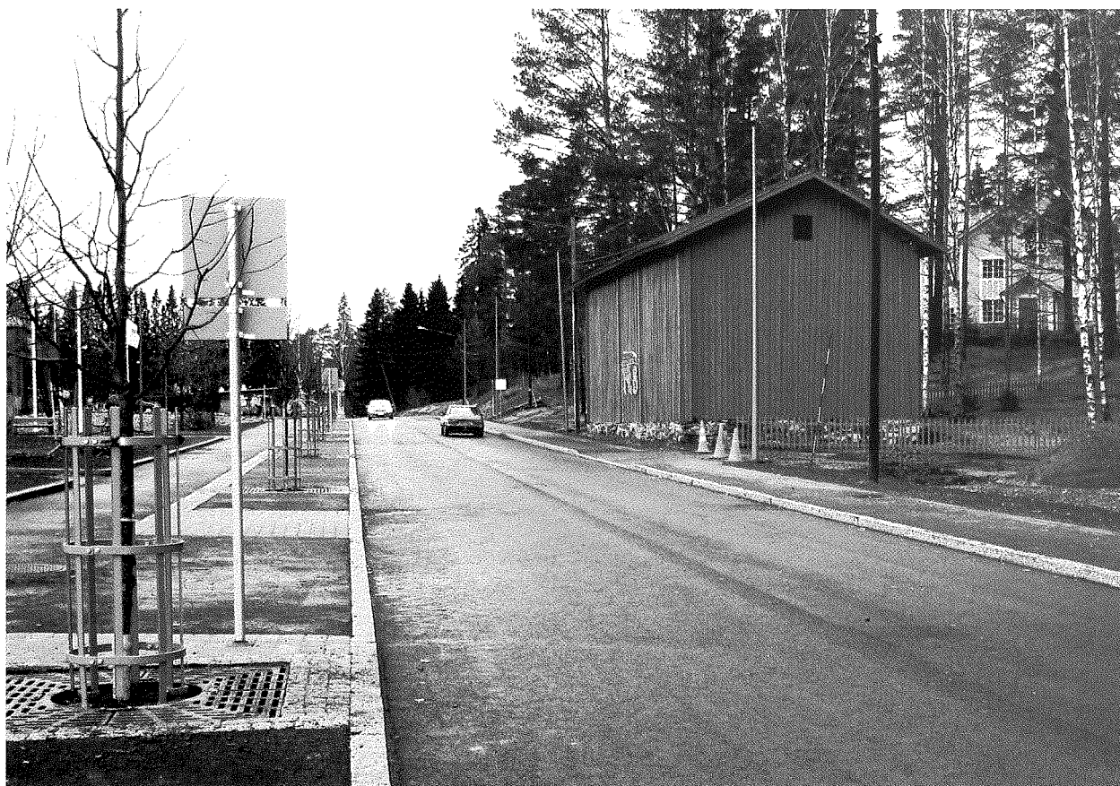
Keskitie oli koko syksyn remontissa ja avattiin liikenteelle uusittuna lokakuun lopulla 2010.
