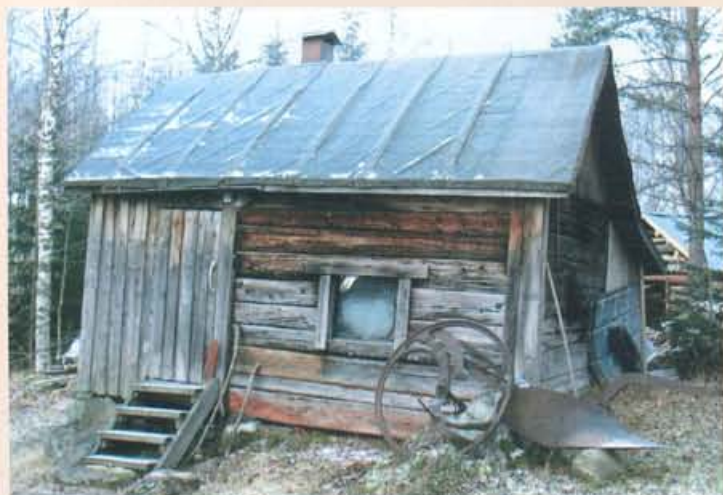
Pentti ja Liisa Leppänen, Tuusniemi Kumpusaari Rakennettu 1941
