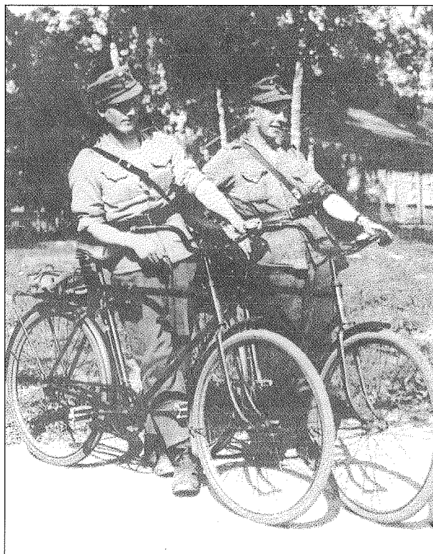
Viestimiesten tehtävä on pitää linjat kunnossa. Vikapartioitehtävässä Toivo Pelkonen ja Viljo Räsänen.
