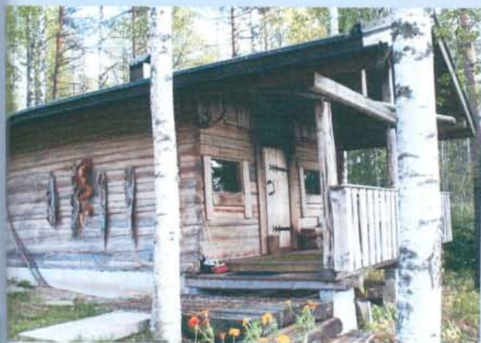
Osmo ja Rauni Hiltusen savusauna Kosulassa Koivuranta-tilalla on rakennettu vuonna 1996.
