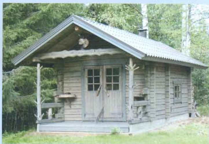
Kalevi Pirskasen savusauna Pajumäessä Koivikon tilalla on rakennettu vuonna 1988.
