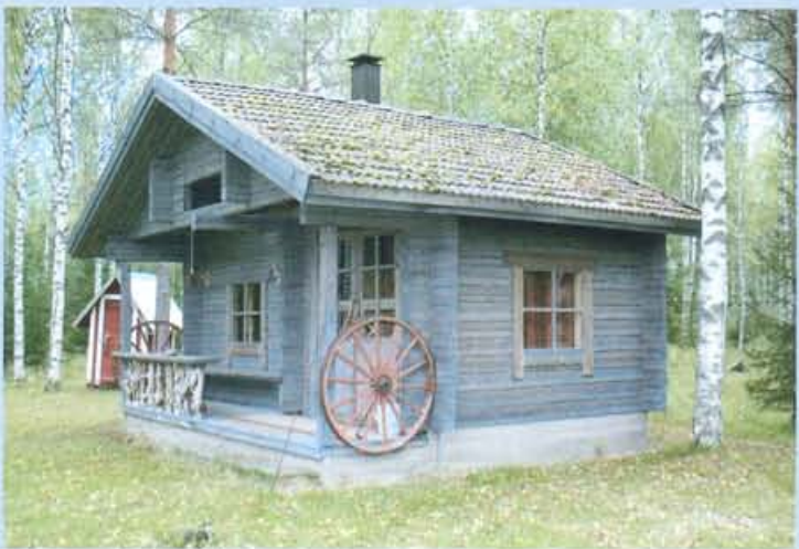
Aaro Pääkkösen savusauna Pajumäessä Nurkkalan tilalla on rakennettu vuonna 1991.
