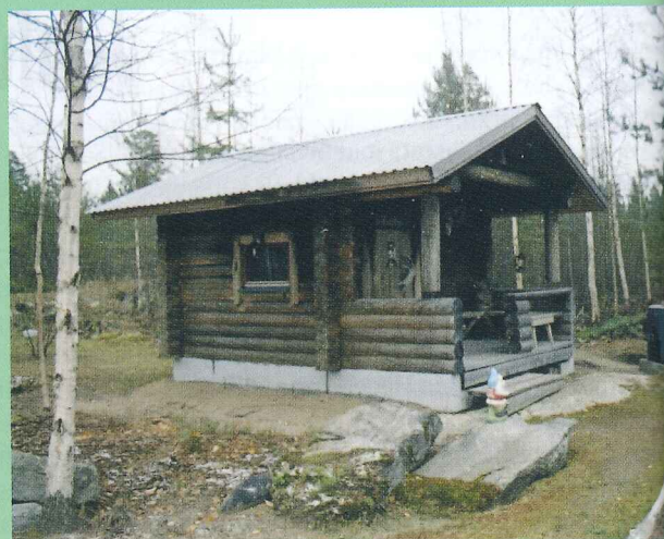
Sijainti: Vihtaniemi, Apajakallio Omistaja: Raija ja Pertti Huuonen Rakennettu: 1999
