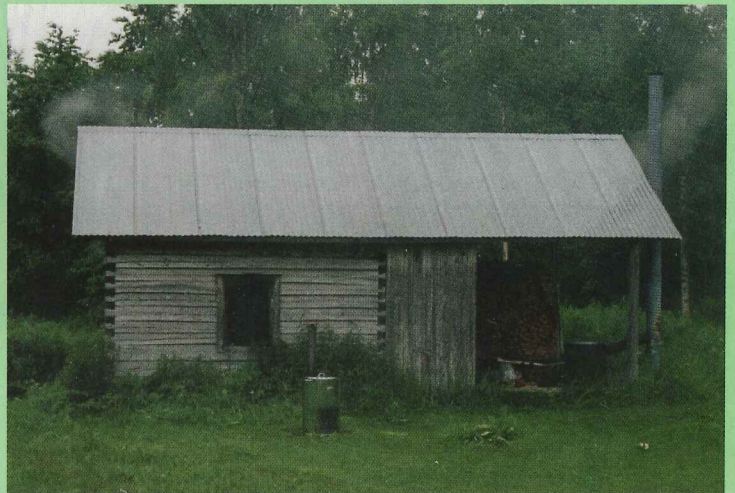
Sijainti: Ruskila, Kivimäki Omistaja: Esteri ja Toivo Poutiainen Rakennettu: 1996
