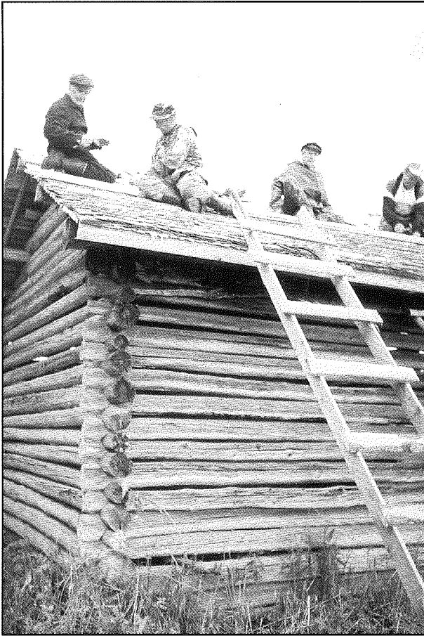
Kotiseutuyhdistys kattoi päreillä ladon Salmenkyläntien varressa vuonna 1993. Kuvassa vas. Lauri Vartiainen, Mauno Itkonen, Onni Ryytänen ja Raimo Savolainen. Kuva: Kotiseutuyhdistyksen arkisto.
