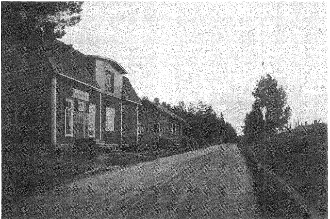
Kunnantupa 1920-luvun lopussa. Kunnantupa takana.
