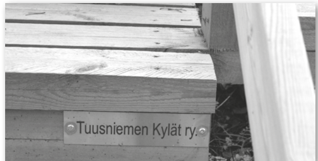
Kuntoportaissa on 178 askelmaa ja lähes jokaisessa rappusessa on hankkeeseen osallistujien henkilöiden, yhdistystyöskien, tai yritysten nimilaatta. Nimilaatoista kertyneet varat Kotiseutuyhdistys käyttää portaiden ylläpitoon.
