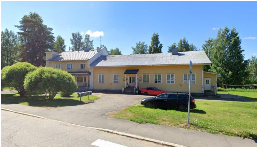
Kuva 31 Entinen kansakoulurakennus Keskitien ja Meijerintien risteyksessä n. kilometri kaakkoon päin. Kuva: Google 2022.
