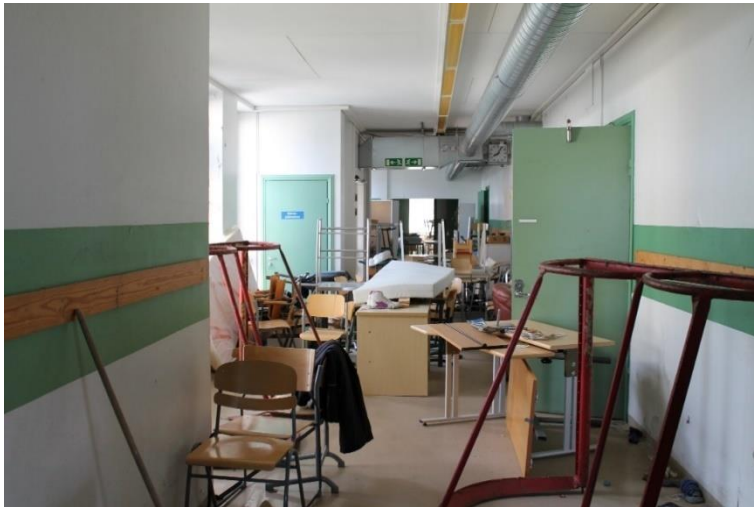
Kuva 163 Ensimmäisen kerroksen käytävänäkymä kaakkoon päin.
