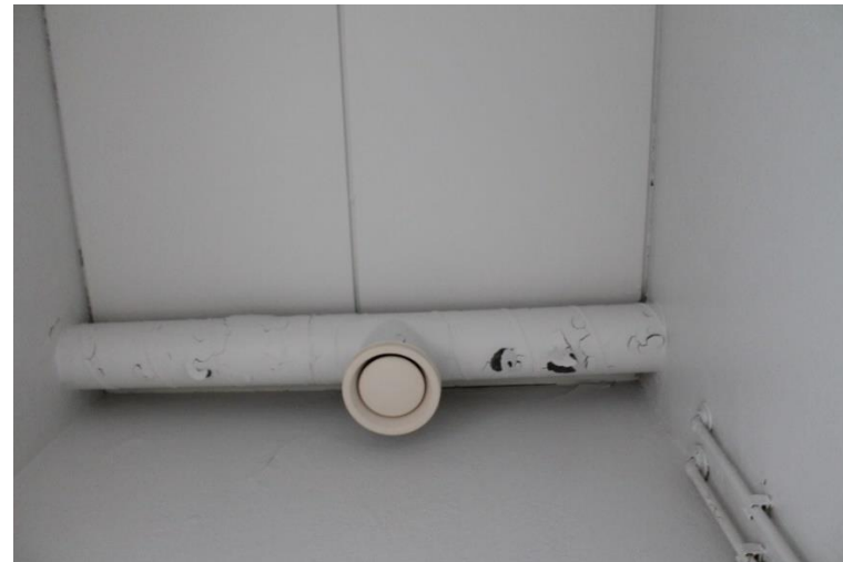
Kuva 175 WC-tilan katossa kulkee ilmanvaihtoputki.
