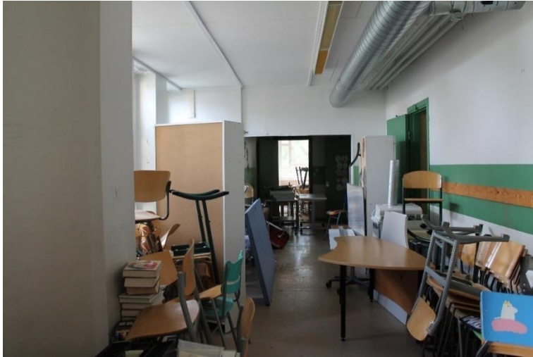
Kuva 93 Näkymä ensimmäisen kerroksen käytävältä kohti kaakkoispäädyn luokkatiloja.
