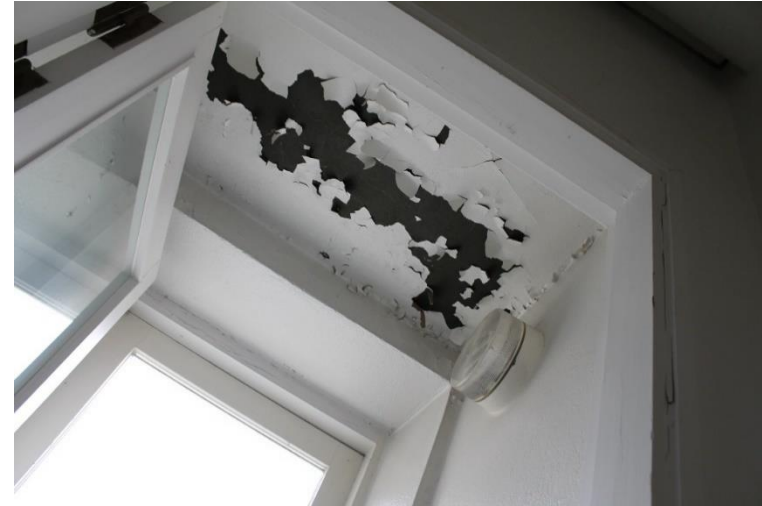
Kuva 183 Luoteen puoleisen siipiosan tuulikaapin katto.
