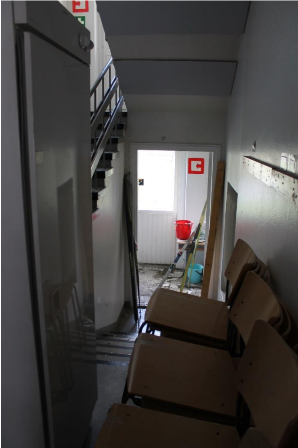
Kuva 137 Näkymä porrashuoneesta takapihan suuntaan.
