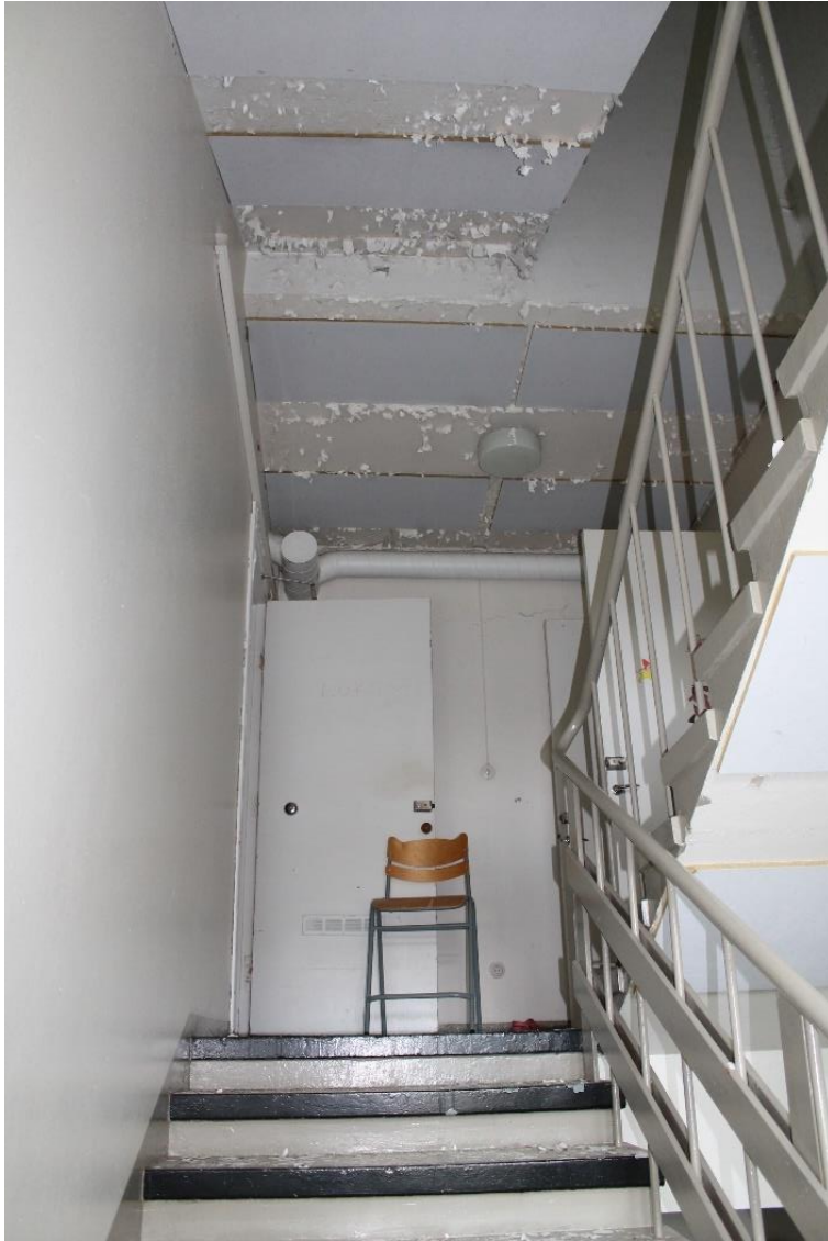
Kuva 201 Näkymä portaikosta toisen kerroksen tasanteelle. Portaat jatkuvat ullakolle.
