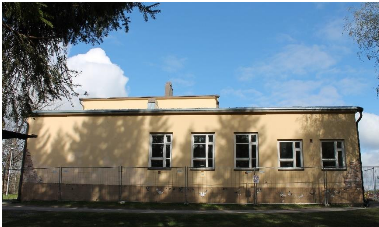
Kuva 82 Yksikerroksisen siiven (idän puoleinen) sivun ikkunoita. Puitejako on epäsymmetrinen. Ikkunoissa on sivulla ja alareunassa tuuletusikkunat, lisäksi kolmessa korkeammassa ikkunassa on koristelista isoimmassa ruudussa. Kahdessa matalammassa ikkunassa ei ole koristelista isoimmassa ruudussa.
