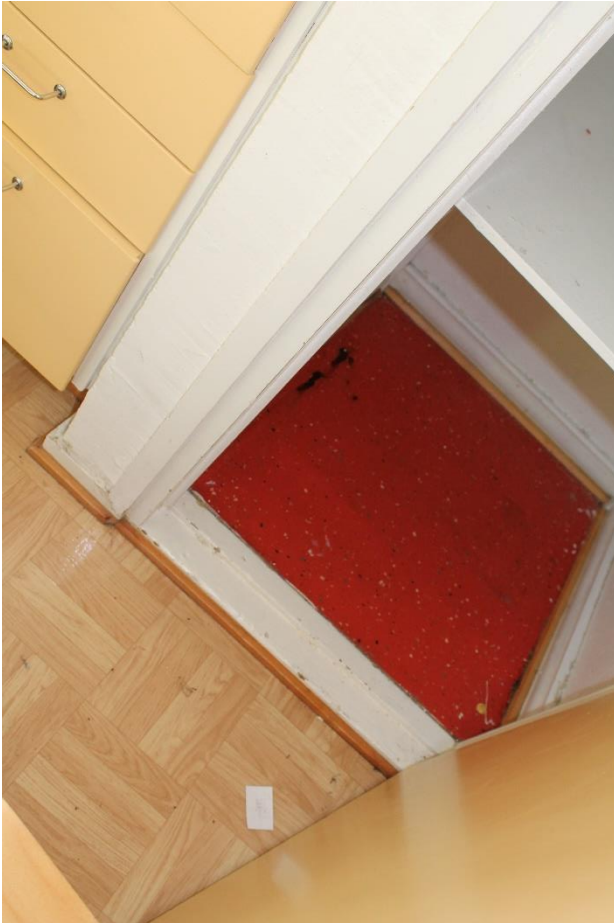
Kuva 254 Ruokakomeron lattiassa on punainen muovimatto.
