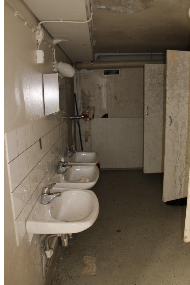
Kuva 262 Poikien saniteettitilat. Lattia on mosaiikkibetonia.
