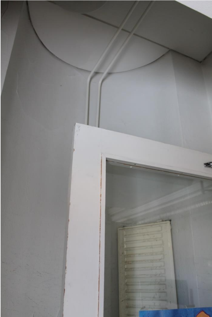
Kuva 91 Tuulikaapin sivuseinissä on puolisyylinterin muotoiset syvennykset molemmin puolin.
