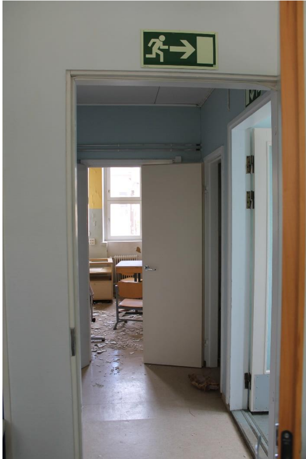
Kuva 112 Näkymä vastaanottotilasta eteisen läpi matalan siipiosan keittiötilaan. Kuvassa oikealla on tuulikaapin ovi.
