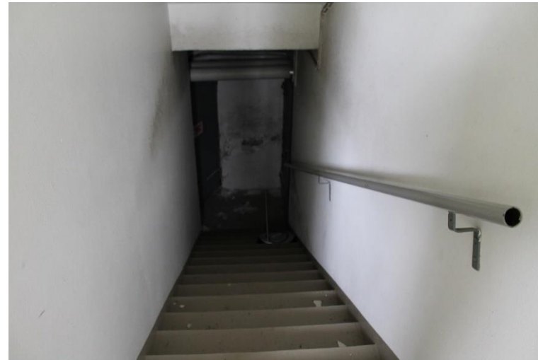
Kuva 282 Rakennuksen keskiosan porrashuoneesta kellariin johtavat portaat.
