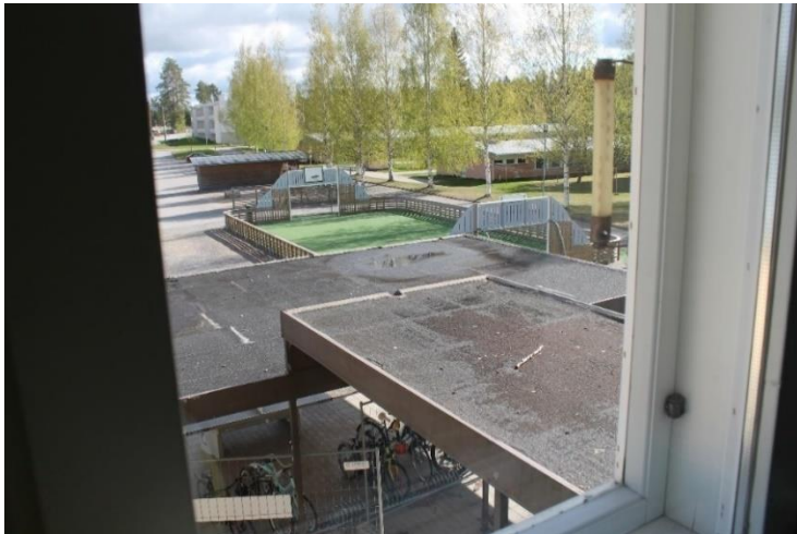
Kuva 72 Sisäpihan katoksilla on tasakatto ja huopakate.
