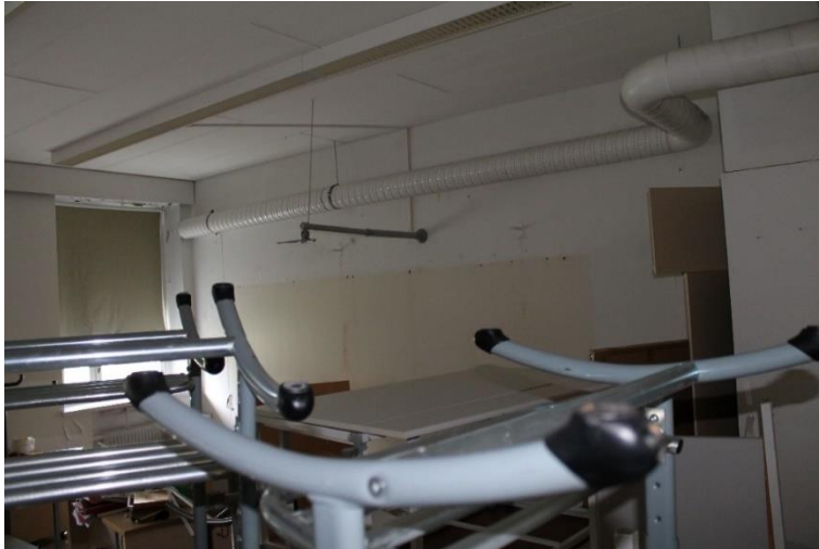
Kuva 134 Osasta luokkahuoneita on irrotettu liitutaulut.
