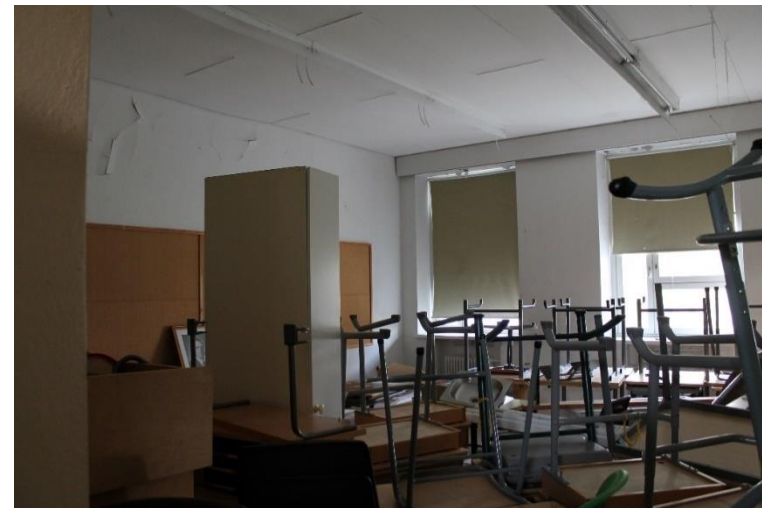
Kuva 133 Käytävältä katsottuna porrashuoneen vasemmalle puolelle sijoittuva luokkatila 109.
