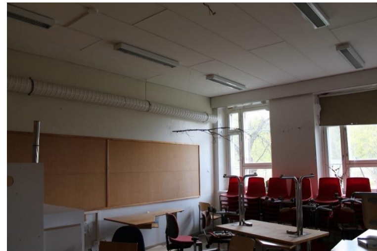
Kuva 148 Käytävältä katsottuna porrashuoneen oikealla puolella sijaitseva luokkatila 110.
