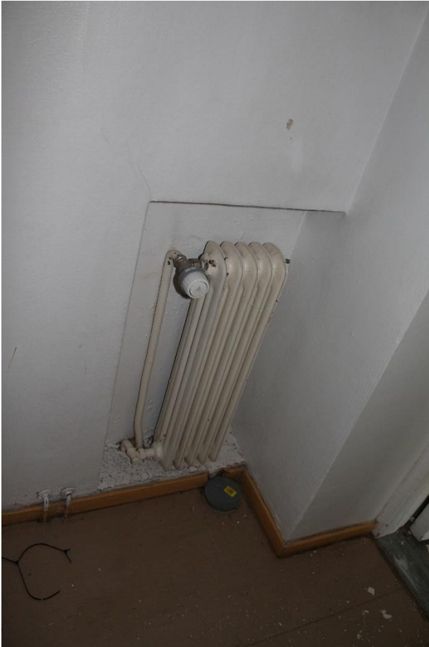
Kuva 203 Seinään lovettu patteri yläkerran eteisessä.
