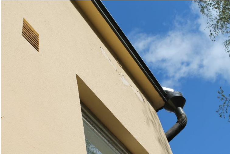
Kuva 75 Räystäiden alapinnat on huoliteltu julkisivun mukaisiksi.
