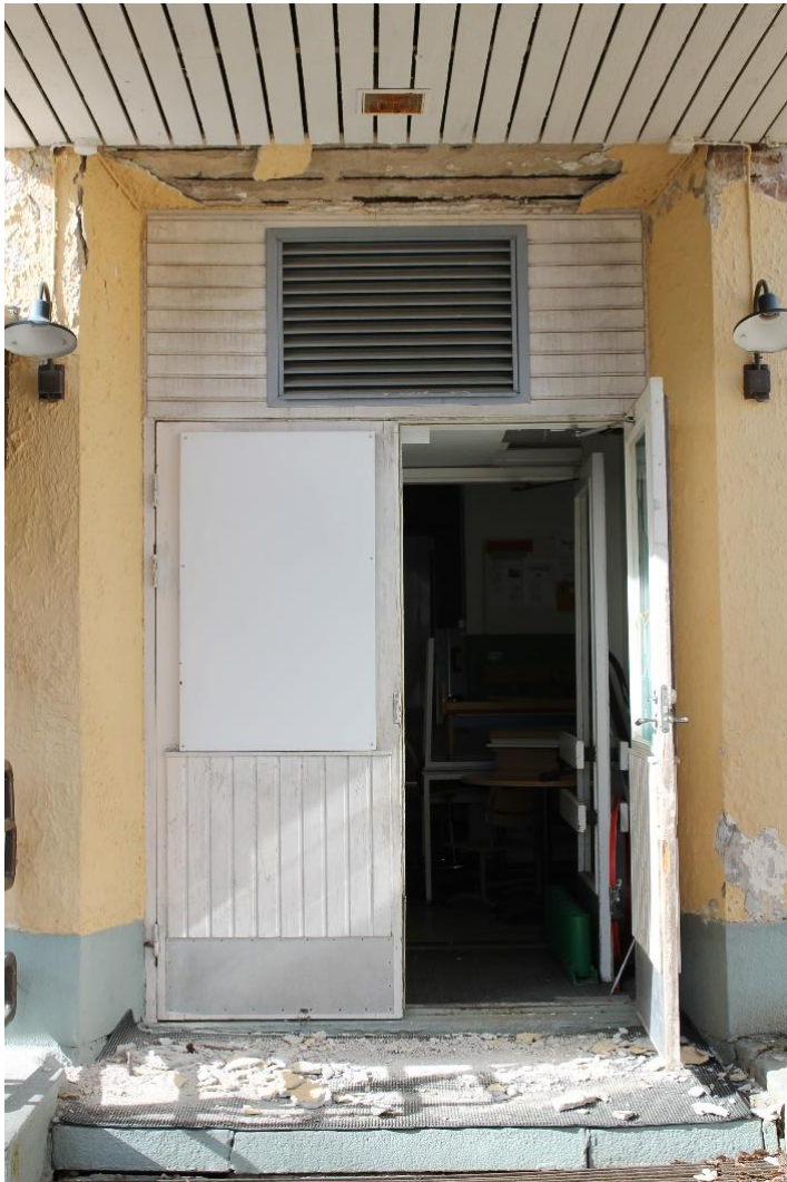
Kuva 86 Ensimmäisen kerroksen pääsisäänkäynti.
