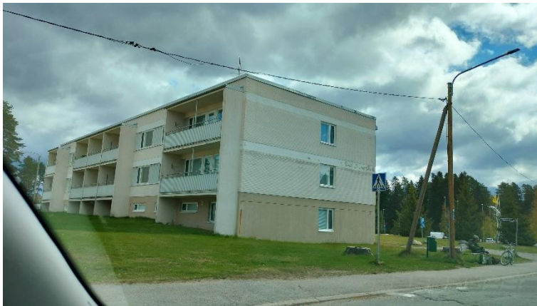
Kuva 24 Keskitien pohjoispuolella sijaitseva 1970-luvulla rakennettu asuinkerrostalo.
