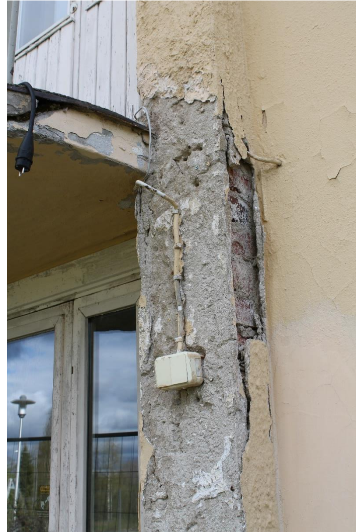
Kuva 58 Takajulkisivun sisäänkäynnin detajiiikkaa. Sisäänkäynnin kehyksen rappaus on karkea, kun taas seinissä rappaus on sileä.
