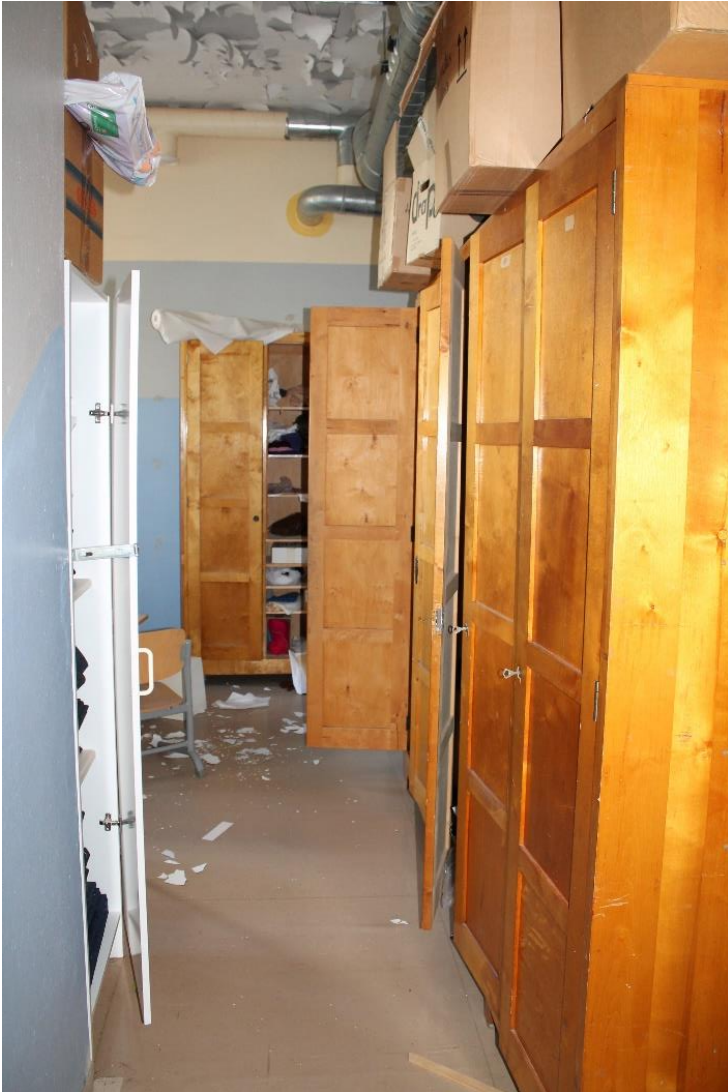
Kuva 193 Entisenopetusvälinevaraston 113 puisia kaapistoja. Viimeisimmäksi tila on toiminut nuorisotilana.
