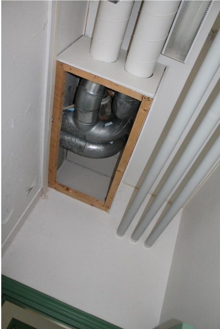
Kuva 189 Ilmanvaihtoputkien puurakenteisia koteloja on auottu.
