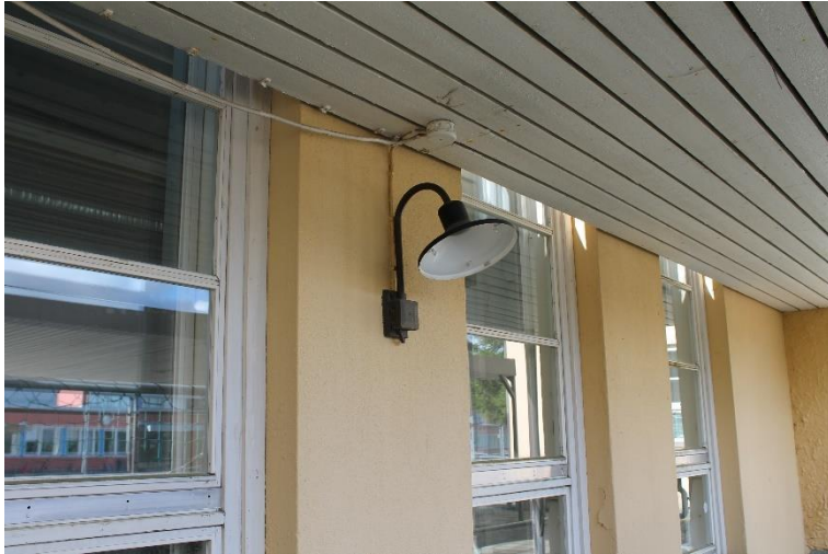
Kuva 68 Ulkovalaisindetaljiikkaa. Valaisin on 1900-luvun alun barn light -tyylinen, mutta minimalistisuutensa vuoksi tuskin alkuperäinen. Sähkötkin rakennus sai vasta 1940-luvulla.
