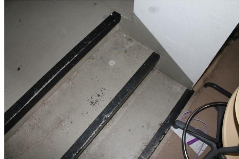
Kuva 136 Sisäportaat, jotka vievät ensimmäisen kerroksen käytävästä porrashuoneeseen.
