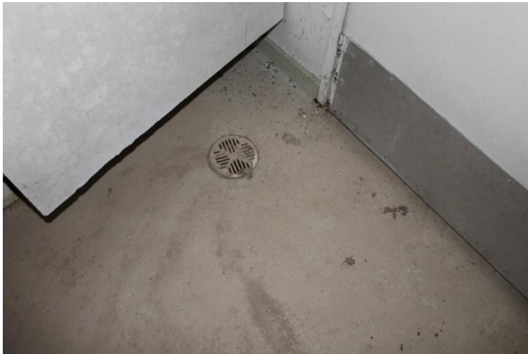
Kuva 281 Betonilattiassa oleva viemäri.
