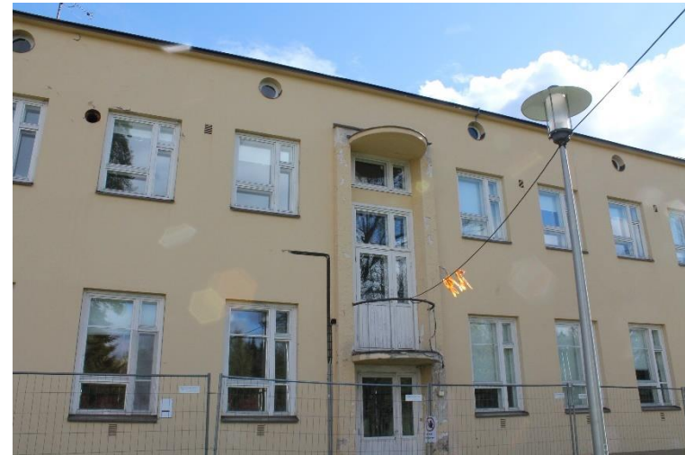
Kuva 77 Parveke ja katos rakennuksen lounaisjulkisivussa.
