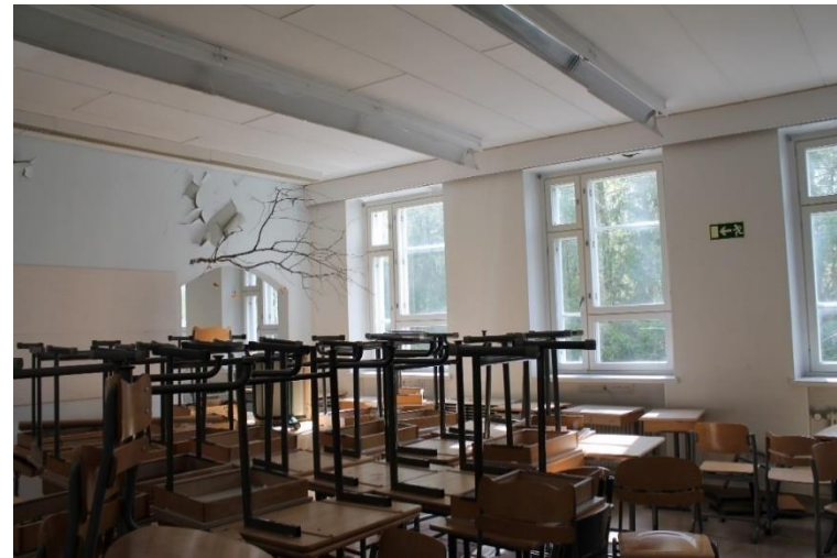
Kuva 104 Luokahuone 107 ensimmäisen kerroksen käytävän kaakkoispäädystä matalan siiven keskiosassa.
