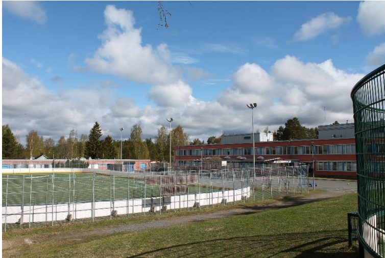
Kuva 19: Näkymä kansakoulurakennuksen luoteispuolelta kohti Tuusniemen yhtenäiskoulun pihaa.
