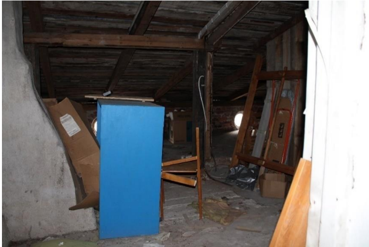
Kuva 305 Ullakon yleisilmettä. Puiset kattorakenteet ovat esillä ja ullakolle on varastoitu mm. kalusteita.
