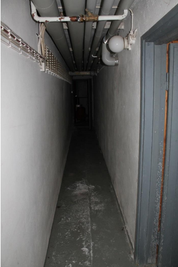
Kuva 288 Kapea porrashuoneesta lämmönjakokeskukseen johtava käytävä.
