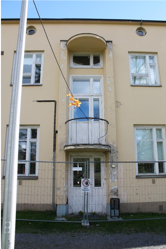
Kuva 57 Takajulkisivun sisäänkäynti rappukäytävään parvekkeineen. Sisäänkäyntiä korostaa pieni sisäänveto ja muusta julkisivusta ulkoneva kehys.
