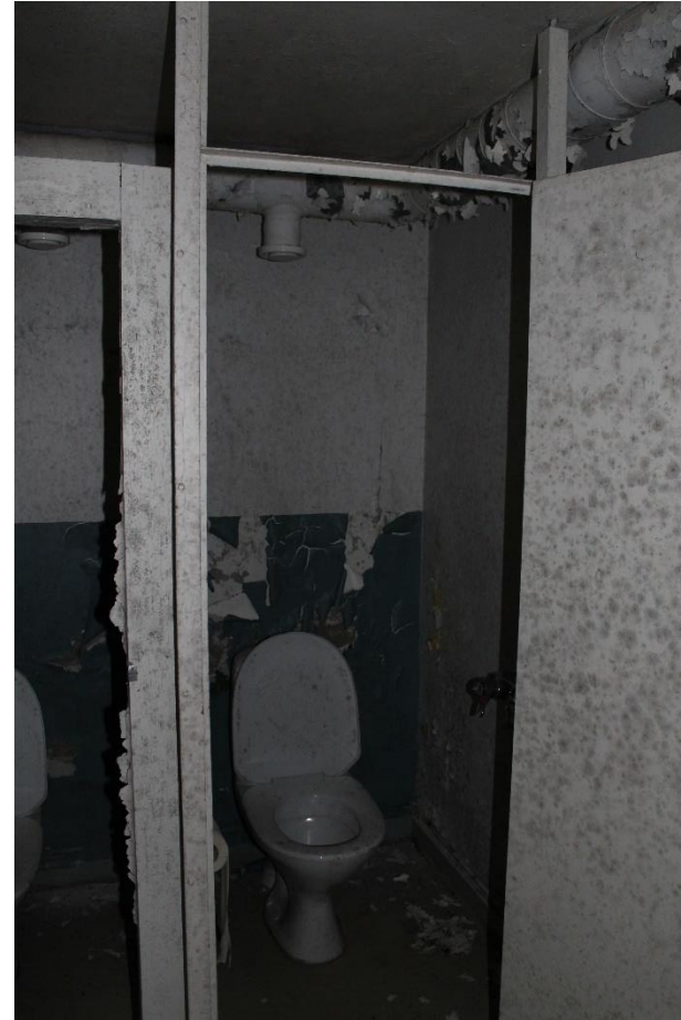
Kuva 279 Vessakoppien rakenteita ja ovilevy.
