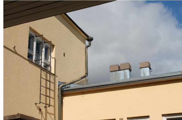
Kuva 73 Myös savupiippujen peltiosat on jätetty maalaamatta siipiosien katoilla.
