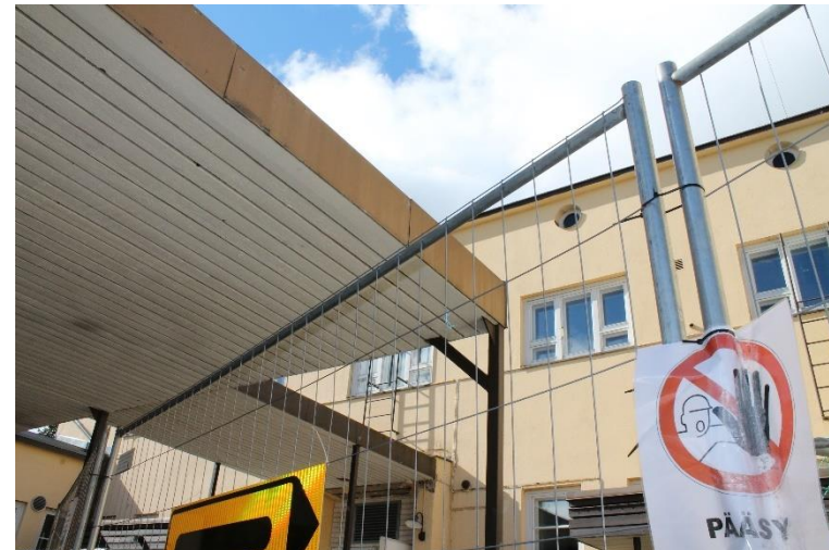
Kuva 62 Pääsisäänkäynnin eteen rakennettu katos. Katoksen alapinta on valkoiseksi maalattua sahattua lautaa. Julkisivun alkuperäinen sommittelu ja detalljiikka jäävät katosten taakse piiloon.
