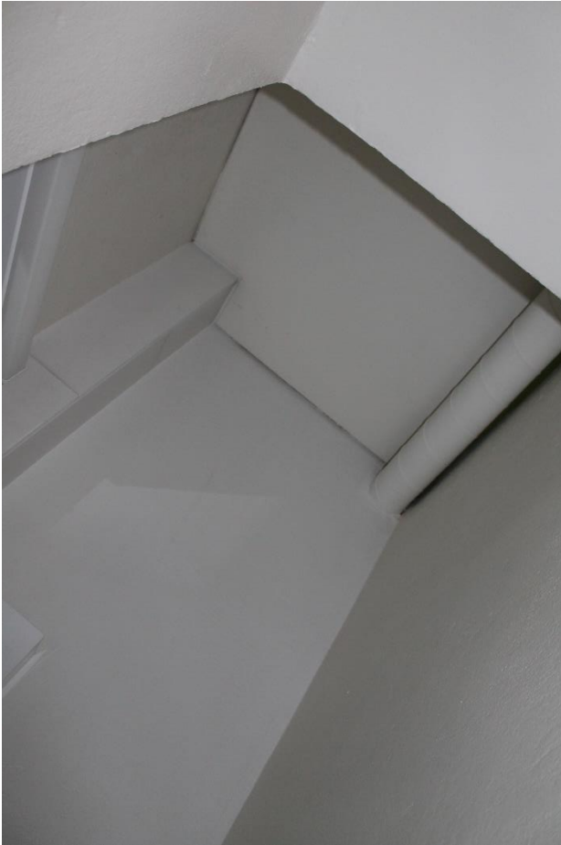
Kuva 223 WC-tiloissa ei ole alakattoa, vaan ne ovat korkeaa tilaa.
