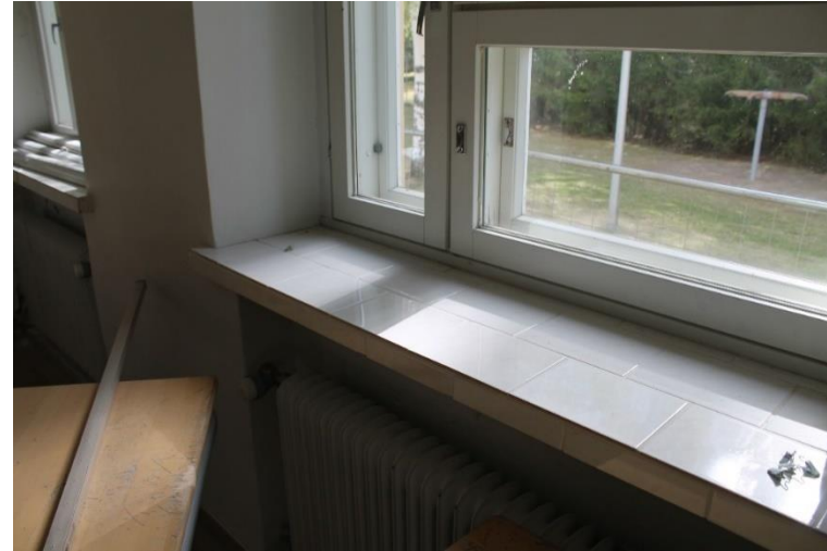
Kuva 107 Luokkahuoneen 107 ikkunalaudat on laatoitettu valkoisilla laatoilla.
