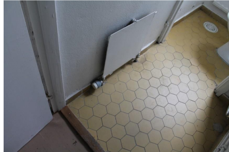
Kuva 174 Siipiosassa sijaitsee erilliset wc-tilat portaikon vieressä. Tilan lattiassa on kuusikulmaiset keltaiset laatat.
