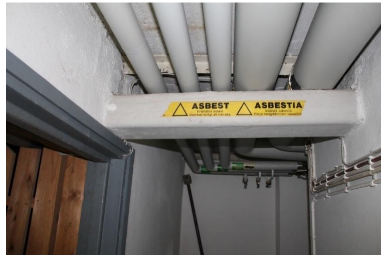
Kuva 292 Asbestieristettyjä putkia kellarin käytävällä.
