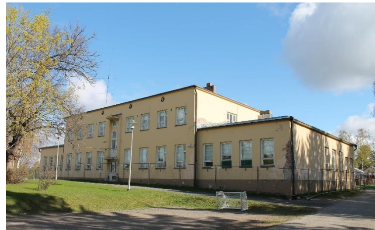
Kuva 80 Takajulkisivu. Kaksikerroksisen rakennusmassan ikkunoiden puitejako on epäsymmetrisiä molemmissa kerroksissa. 1-kerroksisten siipien ikkunat on jaettu neljään osaan pystysuunnassa.
