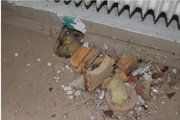
Kuva 130 Luokkahuoneen lattiasta on otettu rakennenäytteitä.
