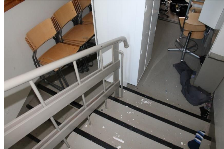
Kuva 138 Porrashuoneen kaiteet ovat pelkistetyt ja rakennusajalle tyypilliseen tapaan siroa metalliputkea. Puset vaakajohteet ovat todennäköisesti myöhempi lisäys.
