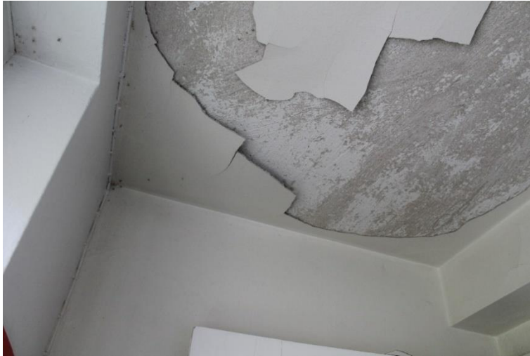
Kuva 143 Porrashuoneen sisäkatto on ollut valkoiseksi maalattu.
