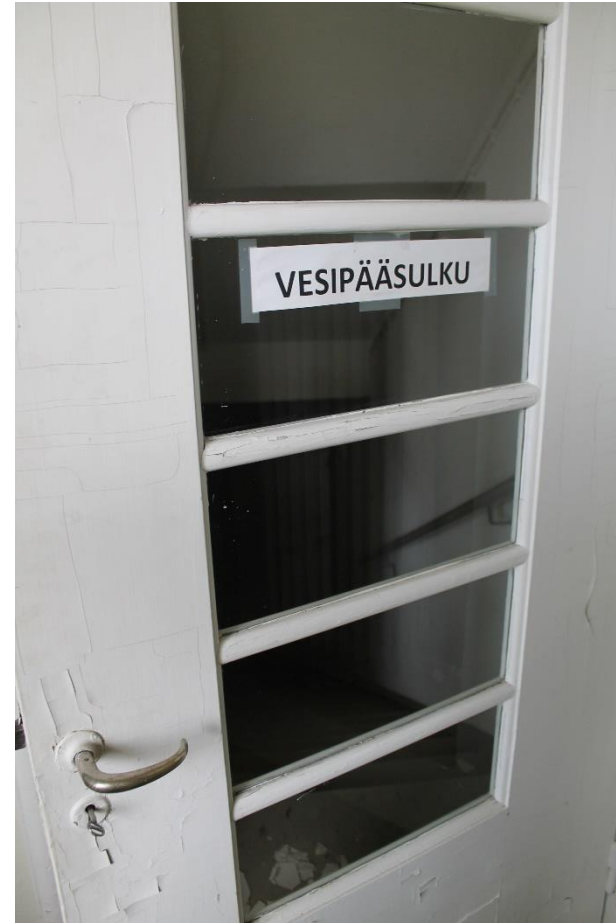
Kuva 145 Kellarin portaisiin johtava ovi portaikon tuulikaapista. Puinen ikkunallinen ovi on mallinsa perusteella alkuperäinen, samoin kuin kahva ja lukko.
