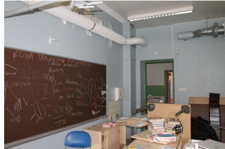
Kuva 129 Näkymä käytävään pain luokkahuoneesta. Luokkahuoneen katossa on erilaisia talotekniikkaan liittyviä putkia näkyvillä.
