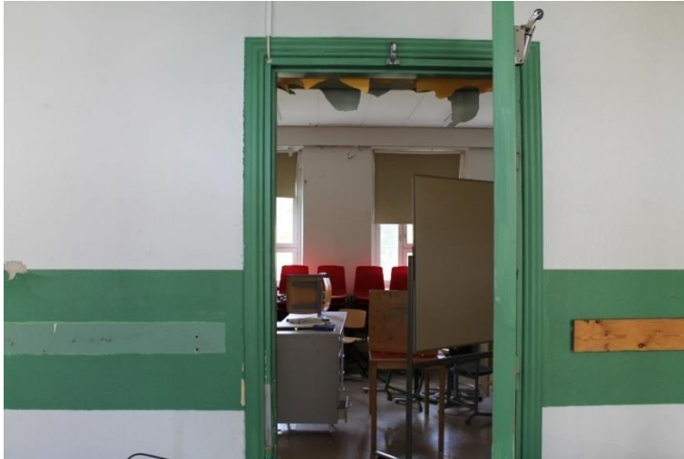
Kuva 166 Näkymä luokkatilaan 110, joka on ollut muun muassa lukion käytössä.
