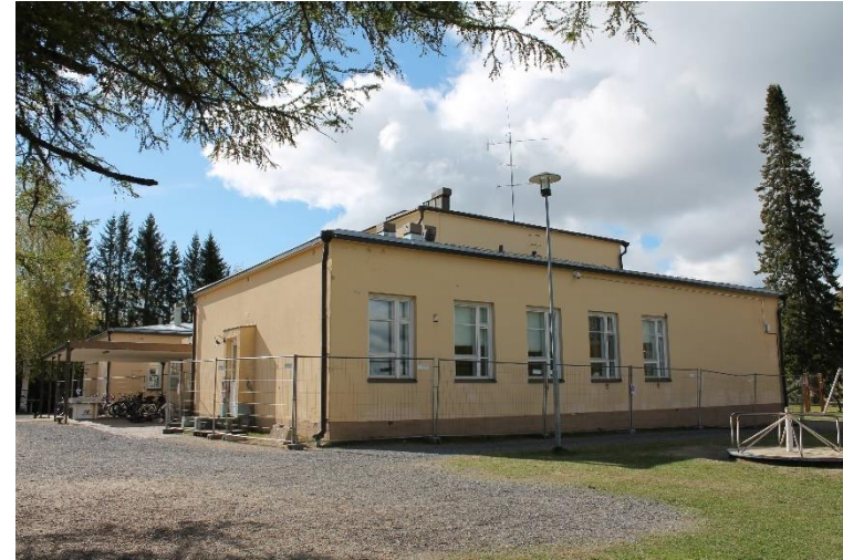
Kuva 83 Yksikerroksisen siiven (lännen puoleinen) sivun ikkunoita. Tässä siivessä ikkunat ovat kaikki samankokoisia.
