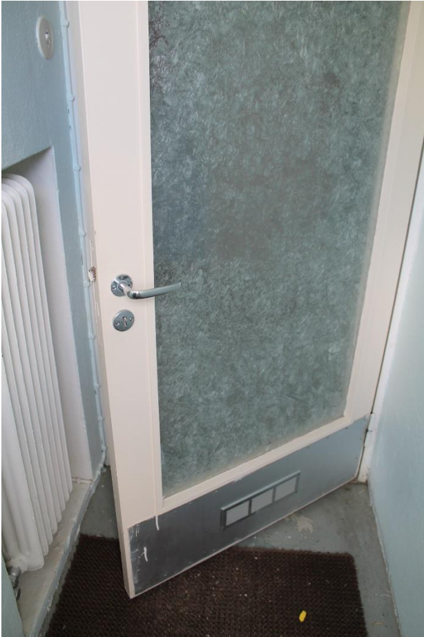
Kuva 114 Tuulikaapin väliovi. Puisessa ovilehdessä on suuri kuviolasi ja potkupelti, johon on asennettu ilmanvaihtoventtiili.
