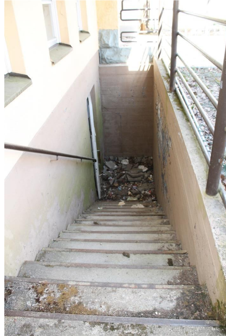
Kuva 273 Portaat tyttöjen saniteettitiloihin.
