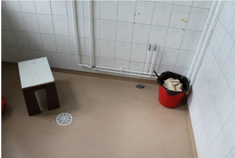
Kuva 178 Suihkutilan lattiassa on ruskea muovimatto ja seinissä valkoiset kaakelit.
