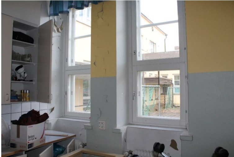
Kuva 122 Keittiötilasta on näkymä siipiosien väliin jäävälle "sisäpihalle".
