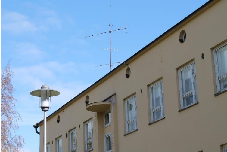
Kuva 81 Takajulkisivun yläkerran epäsymmetrisissä ikkunoissa on sivulla ja alareunassa tuuletusikkunat. Ullakkokerroksessa on pyöreät pienet ikkunat.
