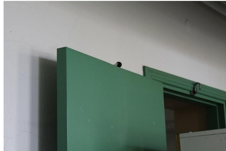
Kuva 103 Luokahuoneen vihreäksi maalattu puuovi ja oviaukon listoitut.
