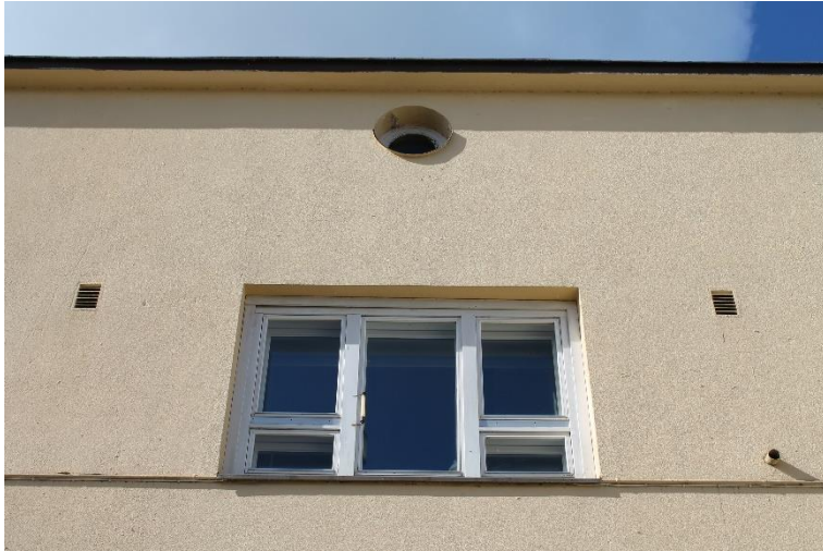
Kuva 85 Etujulkisivun toisen kerroksen ikkunadetaljiikkaa sekä ullakkokerroksen pyöreä pikkuikkuna. Toisen kerroksen ikkunan molemmin puolin näkyy painovoimaisen ilmanvaihdon tuuletusaukot.
