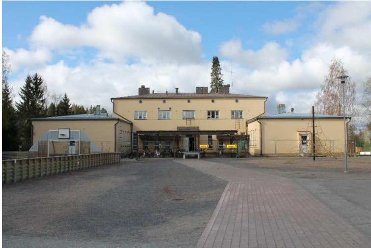
Kuva 47 Rakennusmassa kuvattuna edestä.
