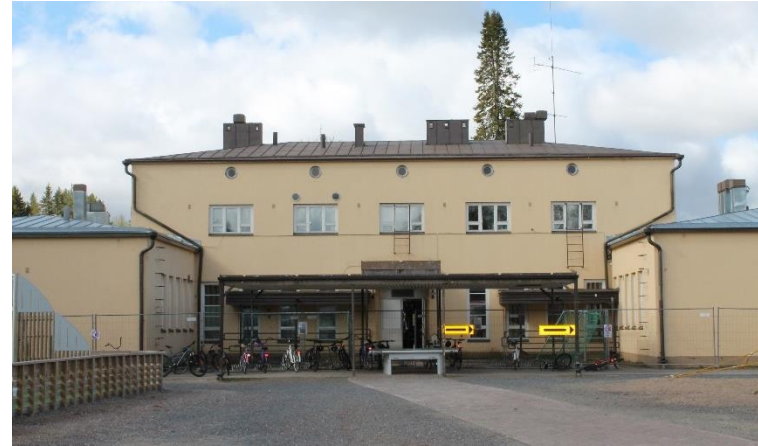
Kuva 79 Etujulkisivu. Sisäänkäynnin päälle rakennettu katos peittää 1. kerroksen ikkunat. 1. kerroksen ikkunat etujulkisivulla ovat kapeita pystyikkunoita, jotka on jaettu pystysuunnassa viiteen osaan. Yläkerran ikkunat ovat symmetrisiä kolmijakoisia vaakaikkunoita, joiden reunimmaisten osien alareunassa on tuuletusikkunat.
