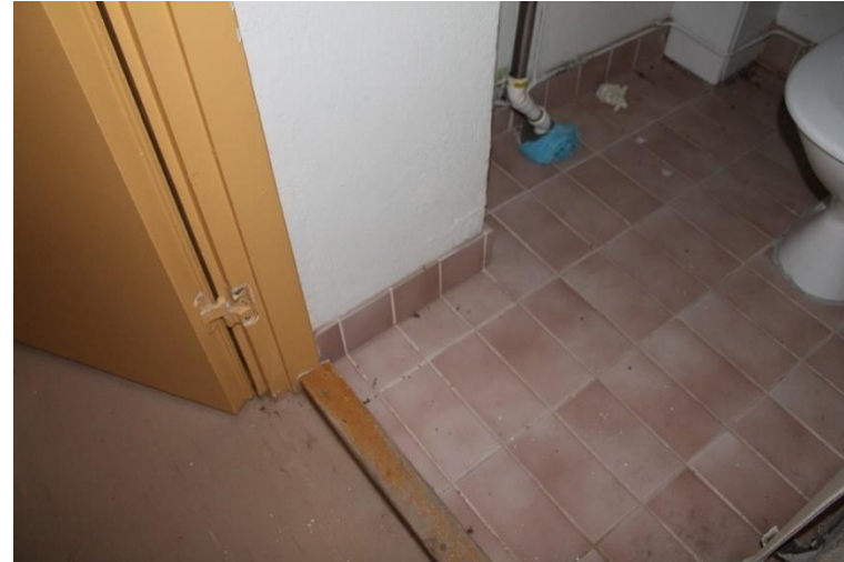
Kuva 222 WC-tilan lattia on laatoitettu vaalean punaisella suorakulmaisella kaakelilla.
