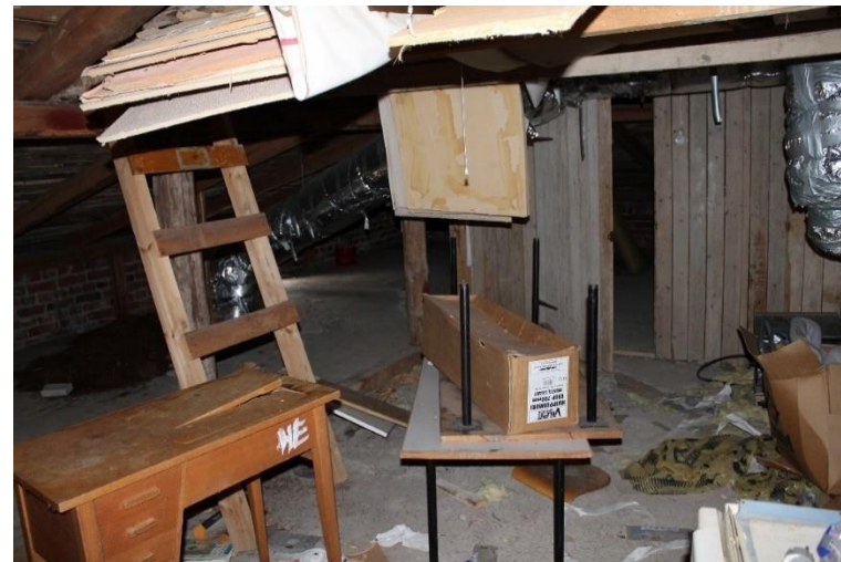
Kuva 308 Ullakolla on lautarakenteisia kylmiä varastotiloja.
