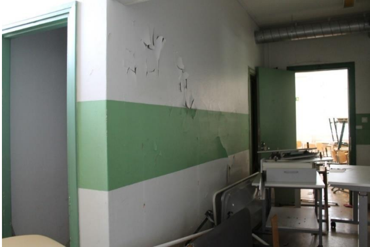
Kuva 98 Käytävän maalattujen seinien värimaailma on valkovihreä. Vihreä väri on samaa sävyä luokahuoneiden vihreiden ovien kanssa. Värimaailma ei ole alkuperäinen.
