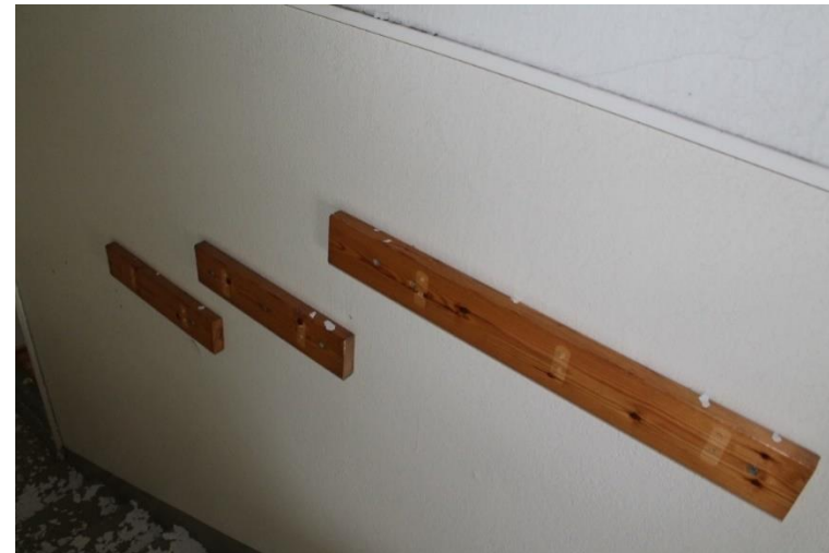
Kuva 259 Porrashuoneen seinään on kiinnitetty lautoja.
