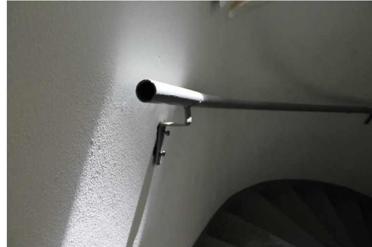
Kuva 190 Siipiosan portaikon käsijohde on siroa metalliputkea.
