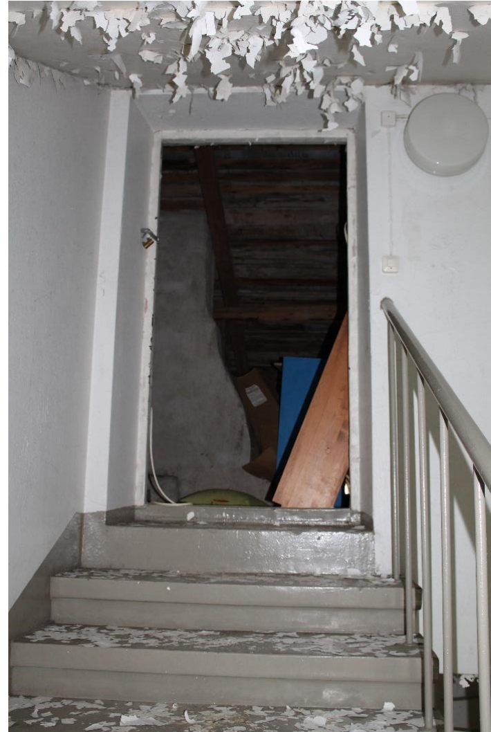
Kuva 304 Portaat rakennuksen korkean osan ullakolle.
