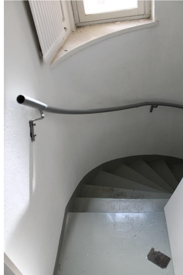
Kuva 298 Kellariin vievät sivuportaat koulurakennuksen matalassa siipiosassa.
