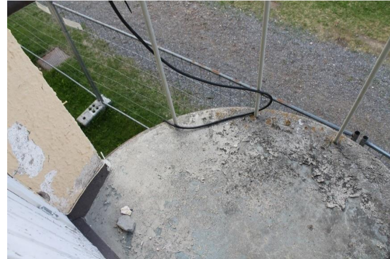
Kuva 199 Tuuletusparveke Kuopiontien puolella.
