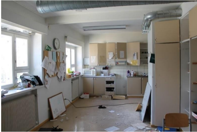
Kuva 211 Keittiöstä purettu väliseinä on sijainnut ikkunoiden välissä. Kuvan oikeassa laidassa näkyvän hyllyn kohdalla on ennen ollut ovi, joka on johtanut seinän toisella puolella sijaitsevaan kieliluokkaan. Kieliluokka ja kuvassa näkyvä tila on aikoinaan ollut osa isointa opettajanasuntoa.
