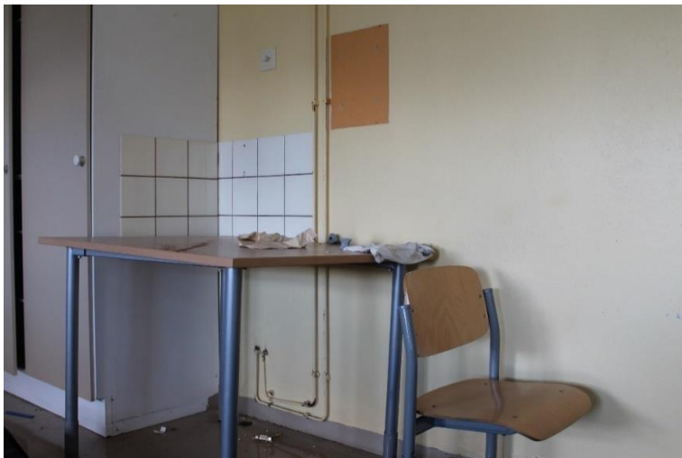
Kuva 156 Vesipiste on siirretty huoneen perältä lähemmäs sisäänkäyntiä tilassa 112.
