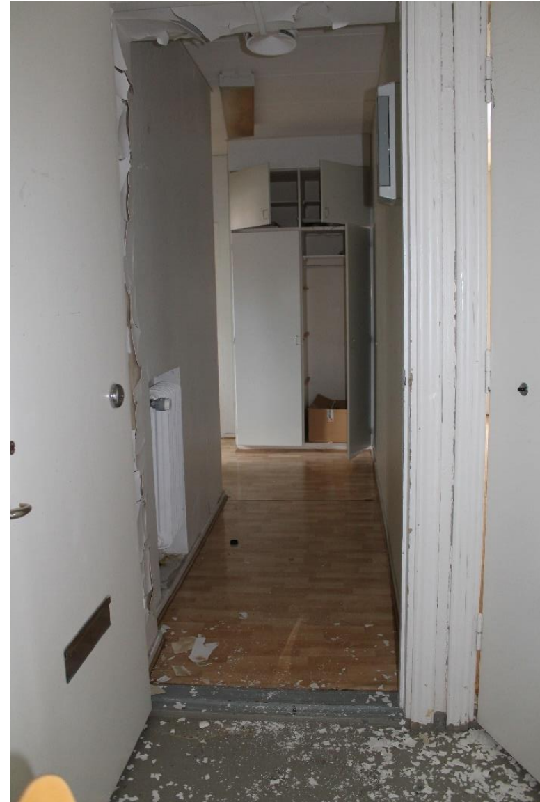
Kuva 224 Näkymä yläkerran porrashuoneesta vanhaan opettajanasuntoon 2. Opettajanasunto 2 sijaitsee rakennuksen keskiosan itäisimmässä nurkassa.
