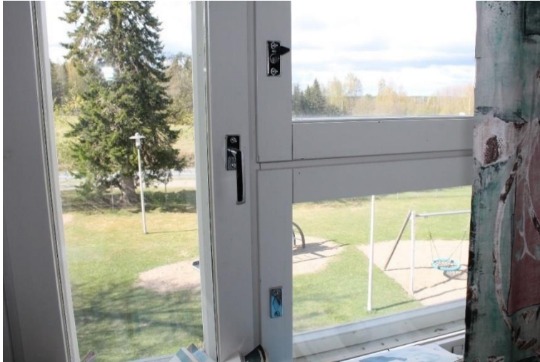
Kuva 218 Kieliluokan ikkuna ja näkymä Kuopiontien suuntaan.
