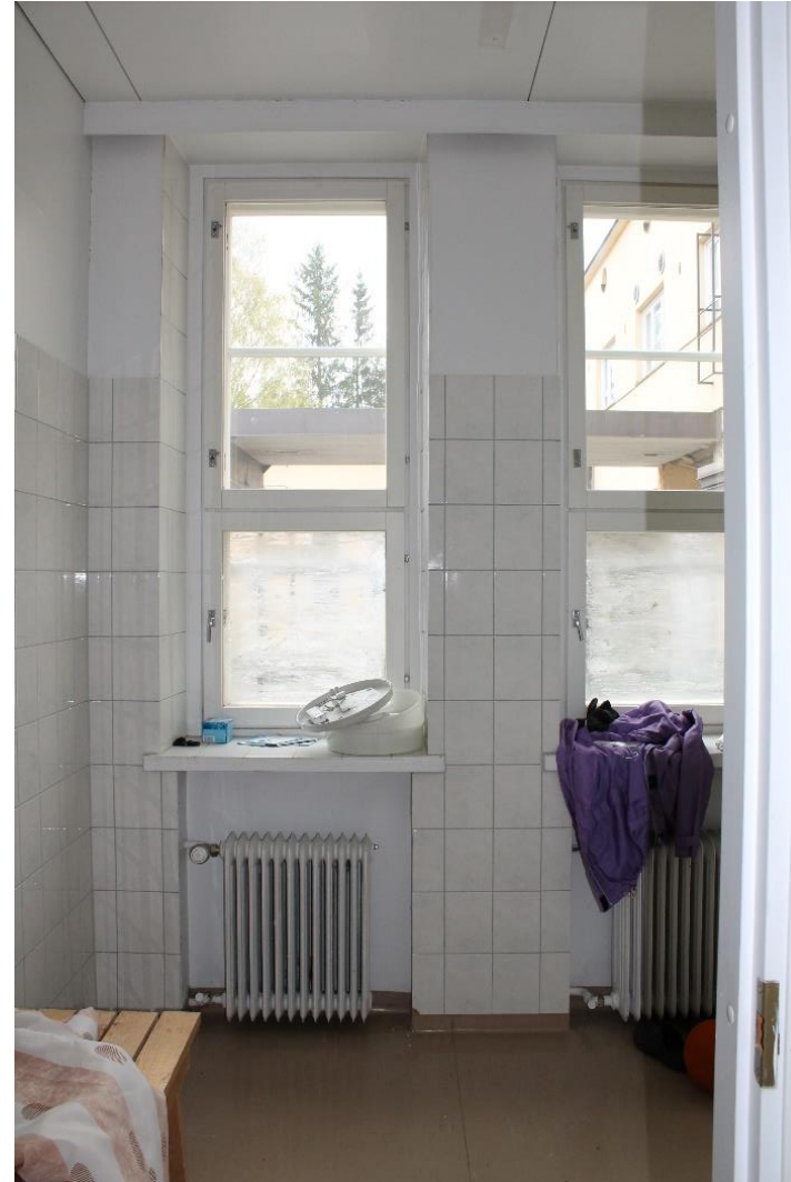
Kuva 177 Etiseen opettajainhuoneeseen 120 on rakennettu jälkeen päin suihkutilat.
