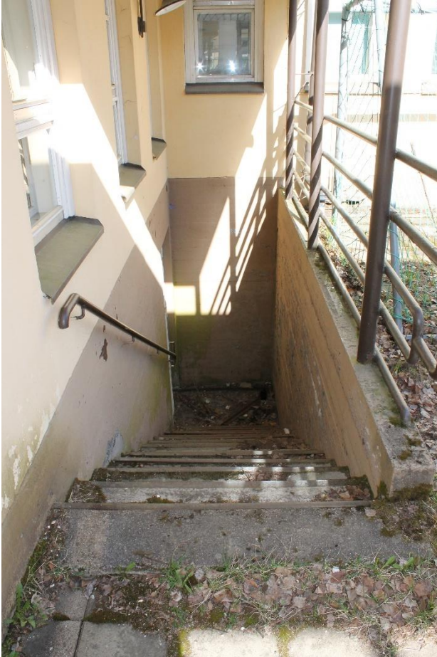
Kuva 261 Koulurakennuksen siipiosien väliin jäävältä "sisäpihalta" johtaa ulkoportaat kellarissa sijaitseviin wc-tiloihin. Kuvassa poikien vessaan johtavat portaat.
