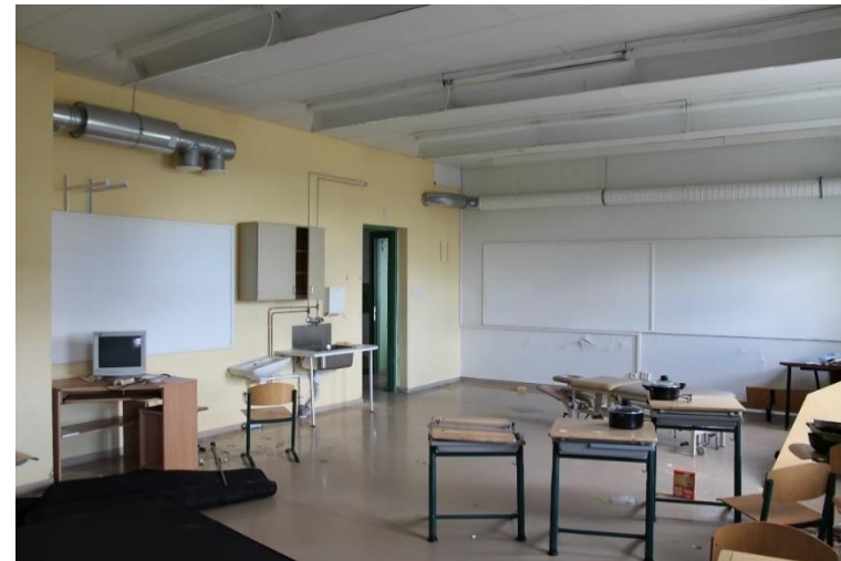
Kuva 154 Kansalaisopiston käytössä olleen luokkatilan 112 seinät on maalattu vaalean keltaisiksi ja valkoisiksi. Luokan lattiapinnat ovat vaalean ruskeaa muovimattoa.
