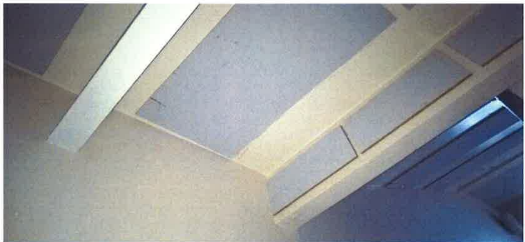
Kuva 15. Käytävillä on mineraalivillaisia eristyslevyjä.
