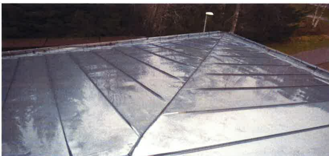
Kuva 22. Vesikate on uusittu matalille osille.
