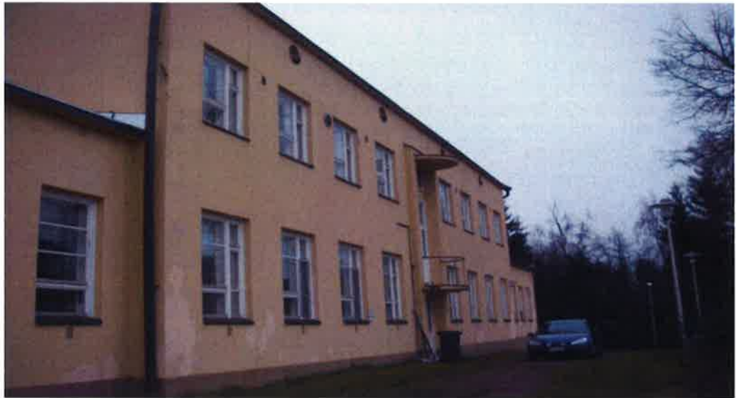
Kuva 1. Ulkoseinärappausta on paikkailtu runsaasti.
