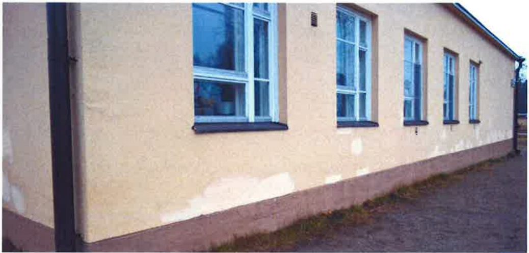
Kuva 8. Paikkauksia rappauspinnoilla.
