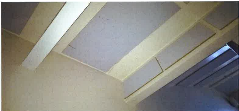
Kuva 15. Käytävillä on mineraalivillaisia eristyslevyjä.
