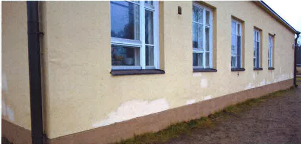
Kuva 8. Paikkauksia rappauspinnoilla.
