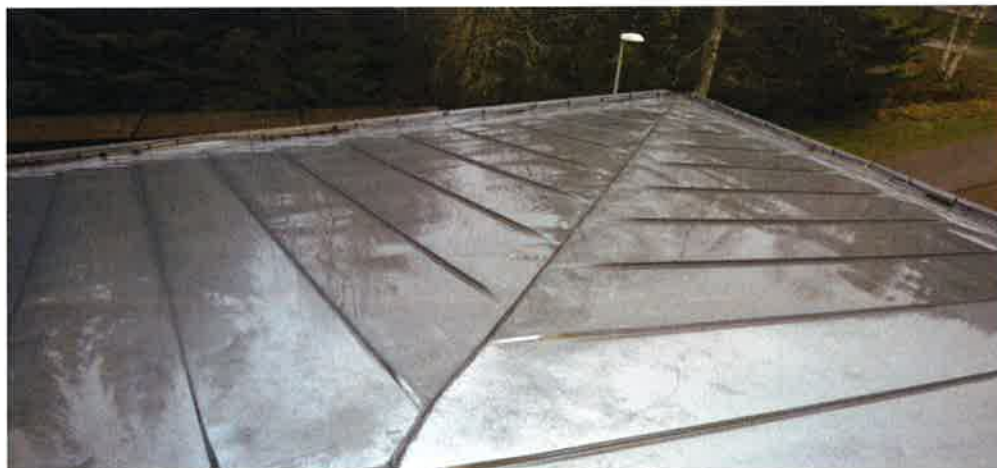
Kuva 22. Vesikate on uusittu matalille osille.
