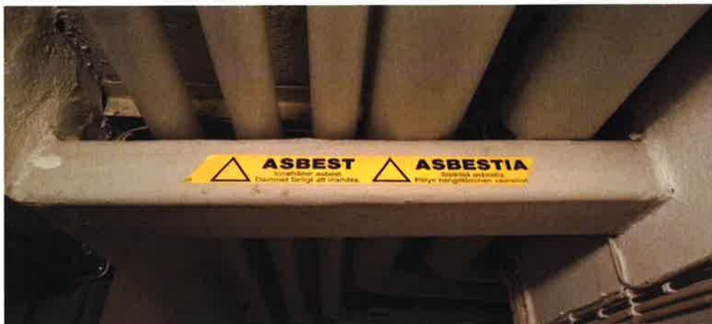
Kuva 11. Kellarissa on asbestilevyrakenteisia iv-kanavia
