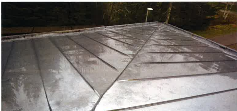
Kuva 22. Vesikate on uusittu matalille osille.
