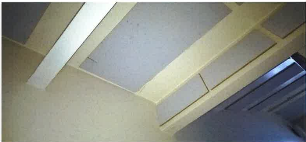
Kuva 15. Käytävällä on mineraalivillaisia eristyslevyjä.
