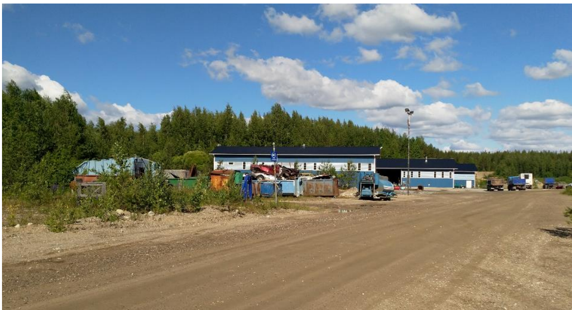
Kuva 9. Suunnittelualan pohjoisosan rakeenuskantaa.
