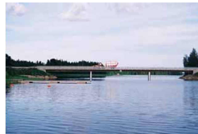
Pahkasalon saareen johtava Kaasilansalmen silta.
